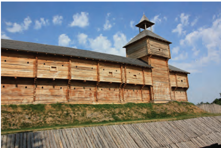
Зрубні стіни, вежі, вал та рів замку-цитаделі фортеці Батурина XVII ст. Реконструйовано на основі археологічних даних у 2008 р. Світлини В. Мезенцева.
