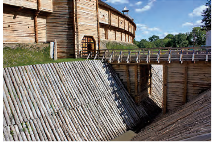
Іл. 20. Відбудовані з брусів стіни, надбрамна вежа, вал, рів, обкладений колодами, та міст до брами цитаделі. Світлини її укріплень і споруд В. Мезенцева.
