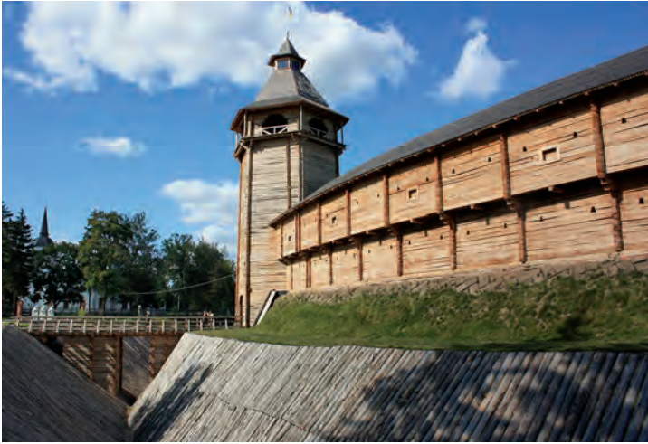
Іл. 20. Відбудовані з брусів стіни, надбрамна вежа, вал, рів, обкладений колодами, та міст до брами цитаделі. Світлини її укріплень і споруд В. Мезенцева.
