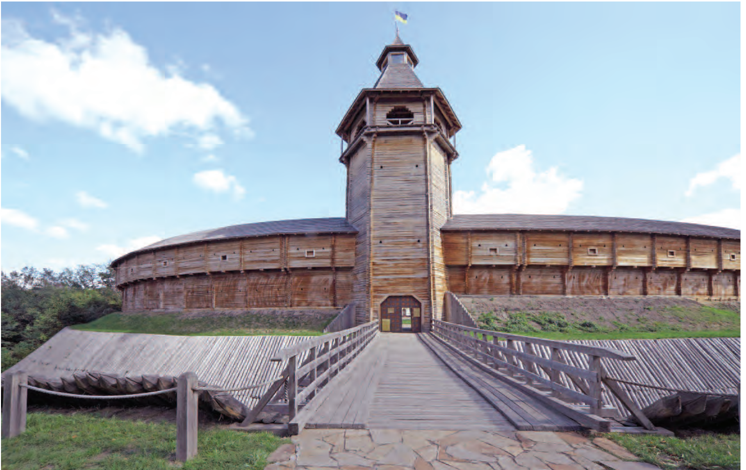
Зрубні стіни, вежа з брамою і мостом, вали й рови цитаделі фортеці Батурина XVII ст. Реконструйовано на базі археологічних даних у 2008 р. Світлина М. Турчина.
