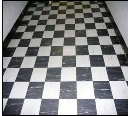
Vinyl asbestos tile (VAT)
