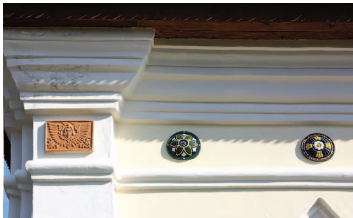
іл. 19. Фрагмент реконструйованої 2008 р. цегляної гетьманської резиденції на цитаделі Батурина, оздобленої керамічними полив'яними розетками та копіями теракотової кахлі з янголом типу 72 на фризі антаблементу.
